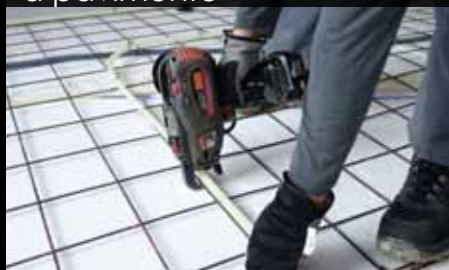
Riscaldamento a pavimento
