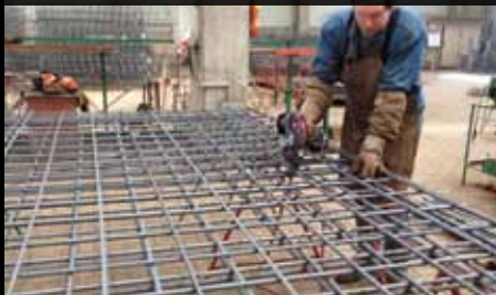
Armature per i prefabbricati
